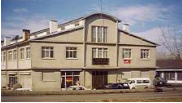
Borsamız Merkez Binası Eski Hali
