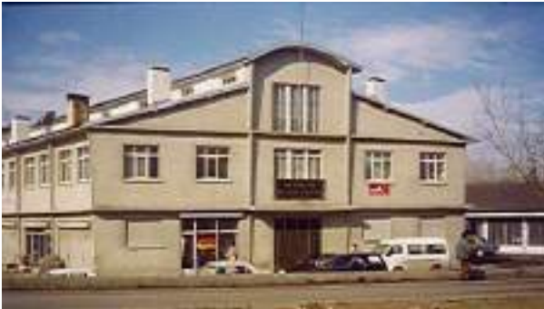
Borsamız Merkez Binası Eski Hali
