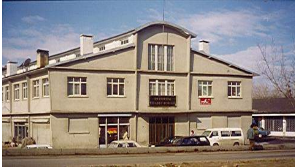
Borsamız Merkez Binası Eski Hali
