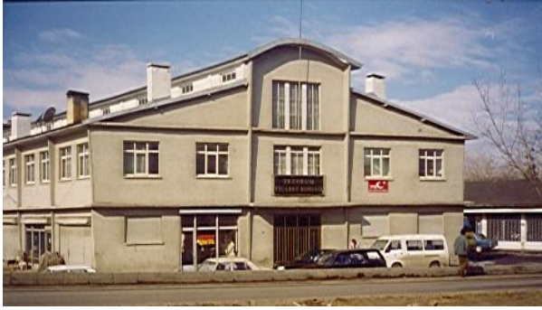
Borsamız Merkez Binası Eski Hali
