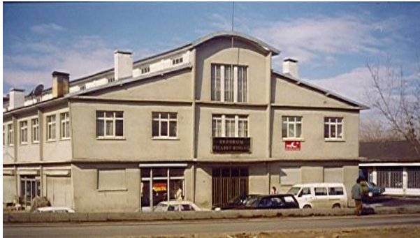
Borsamız Merkez Binası Eski Hali
